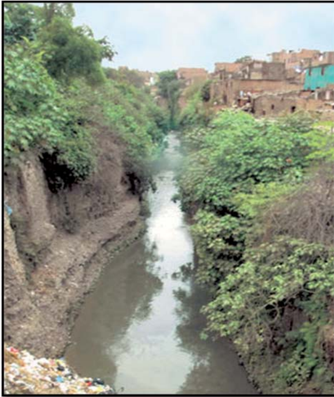
Gran socavamiento del cauce del río Rímac
